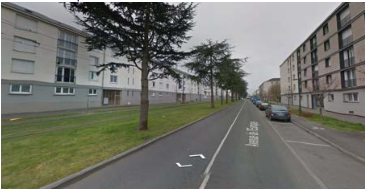
L'Avenue de l'Europe après travaux
